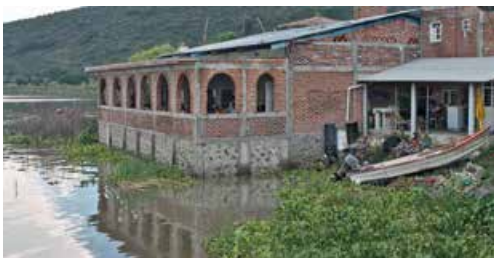
Figura 9. Construcción ilegal en Petatán
