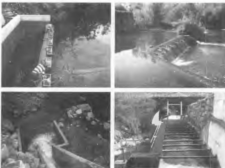
Figura 6.4 a-d Escalas sencillas para peces (España)
