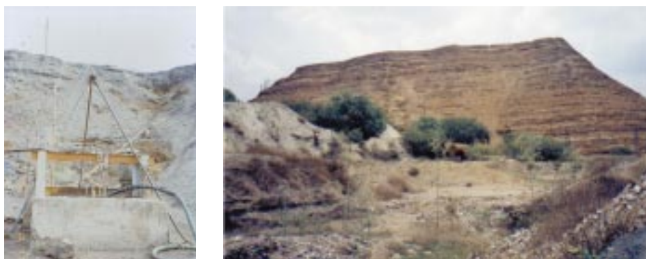
FIGURA 3. Depósitos de jales en Zimapán. Al pie de algunos de estos residuos se ubican norias que son utilizadas principalmente para riego. Además, ocasionalmente, durante la época de estiaje, se utilizan como fuentes de abastecimiento de agua para usos domésticos.
