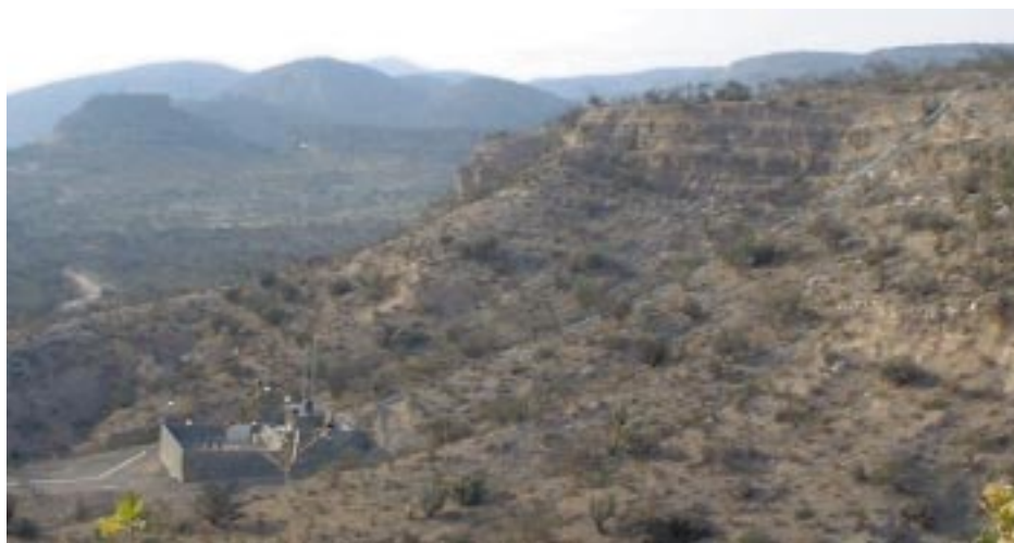
FIGURA 7. Vista de una de las estaciones de rebombeo del sistema Tasquillo-Zimapán. Este sistema es una de las alternativas para dotar a Zimapán de agua libre de arsénico.
